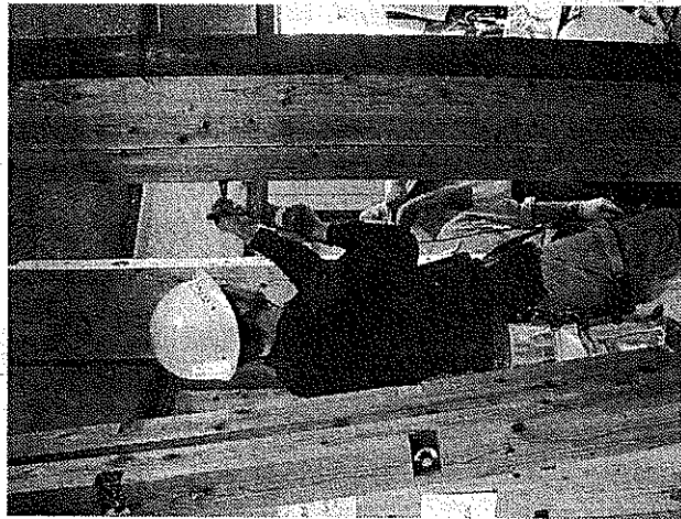
6月15日に行われたモデル施工現地検討会。大阪市内の一般民家で行われた。今ある柱の間をスギ材で埋めていく
