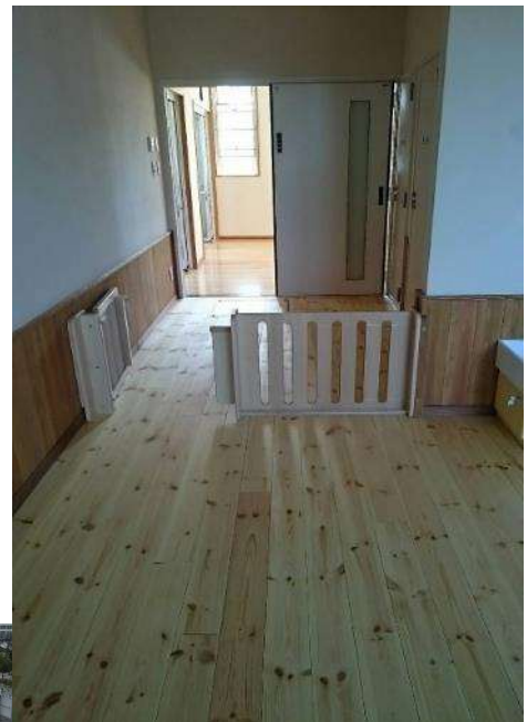
保育園の木質化(フローリング)
